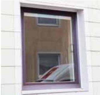
Das alte Fenster ist mittlerweile undicht, so geht wertvolle Heizenergie verloren.
