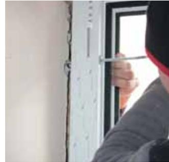
Das neue Fenster wird ruckzuck montiert, verschraubt und eingeschäumt.
