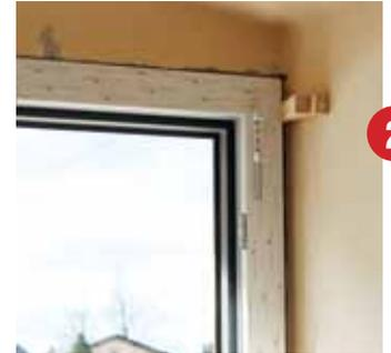
Die Dichtmasse sorgt für ÖNORM-geprüften Maueranschluss.
