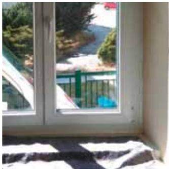
Nun kann die Fensterbank montiert werden und die Fensterflügel werden eingehängt. Kleine Schäden am Innenputz werden ausgebessert. Kunststoffleisten mit Silikonfuge sorgen für sauberen Anschluss an die Fensterlaibung.
